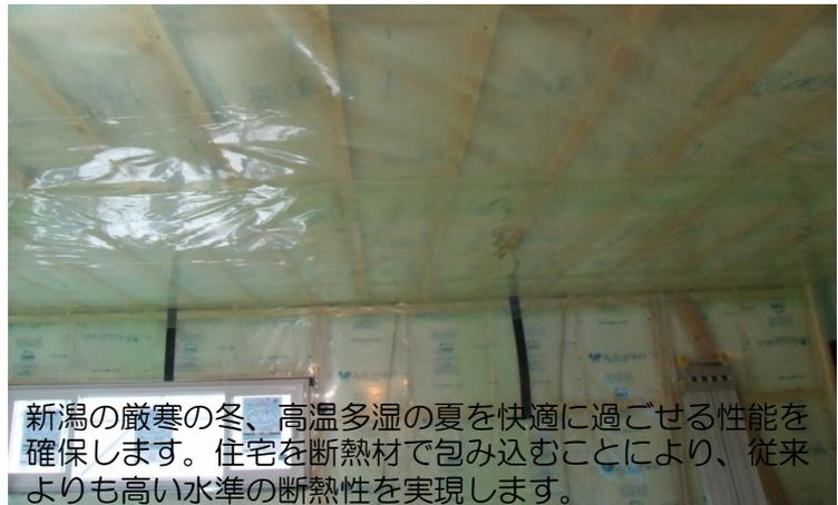
新潟の厳寒の冬、高温多湿の夏を快適に過ごせる性能を確保します。住宅を断熱材で包み込むことにより、従来よりも高い水準の断熱性を実現します。
